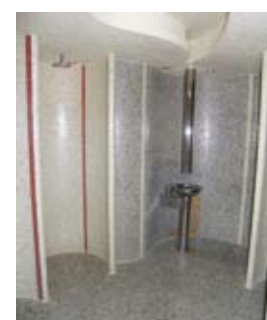
Paneles de poliestireno extrudido reforzado con malla de fibra de vidrio para conformar particiones singulares. Imagen Wedi
