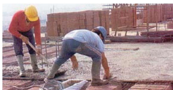
Forjado unidireccional de viguetas, armadura y ejecución
