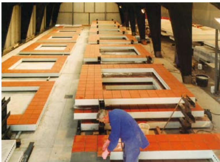
Paneles prefabricados con baldosas cerámicas para una modulación de fachada. Imagen Praxis-Handbuch Fliesen
