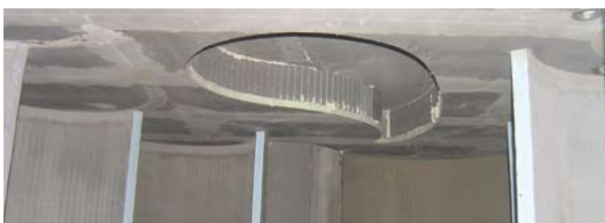
Paneles de poliestireno extrudido reforzado con malla de fibra de vidrio para conformar particiones singulares. Imagen Wedi
