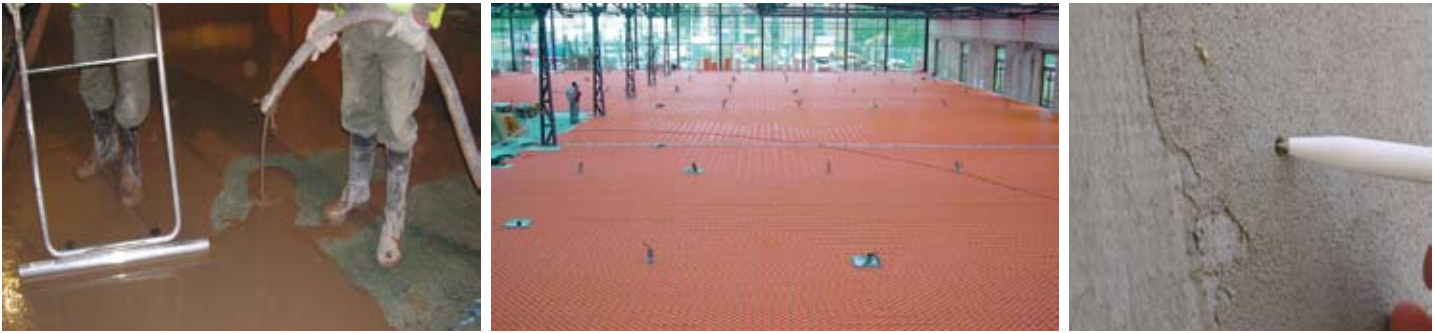
Ejecución de solera con mortero autonivelante como capa de adecuación de la superficie (imagen Kerakoll), calefacción radiante desde el suelo (imagen Schlüter Systems) y cohesión en superficie de colocación (imagen Kerakoll)
